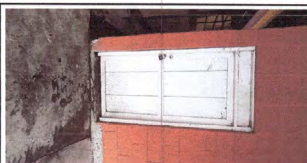
Foto 6: Sustrucción de puerta de madera por metal del modulo # 2
