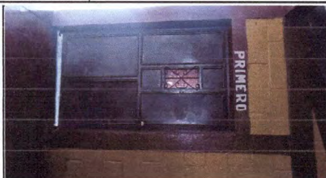
Foto 1: Sustrucción de puerta de metal modulo 1
