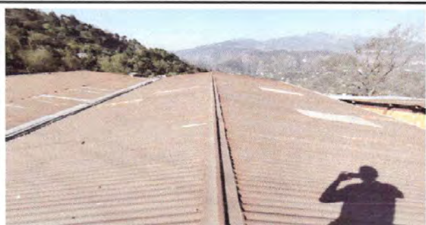
Foto 1: Sustrucción de lámina por lámina troquelada aluzin calibre 26 módulo 1.
