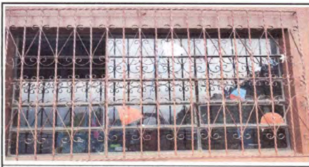
Foto 5: Sustitución de balcón de metal módulo 1.
