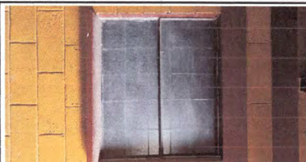
Foto 2: Sustrucción de estructura de metal de ventana por PVC módulo 1
