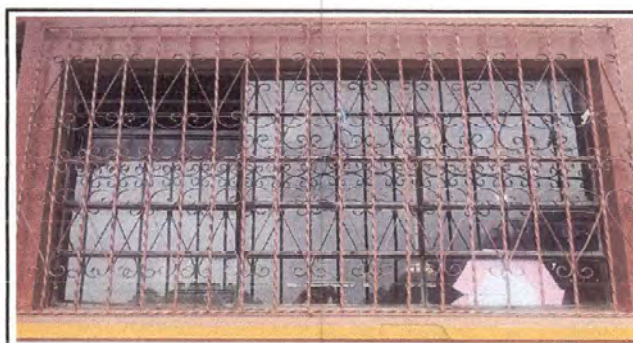
Foto 4: Mantenimiento de balcón de metal módulo 1.
