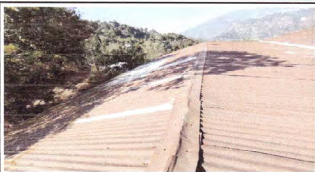
Foto 1: Sustitución de lámina por lámina troquelada aluzin calibre 26 módulo 1.
