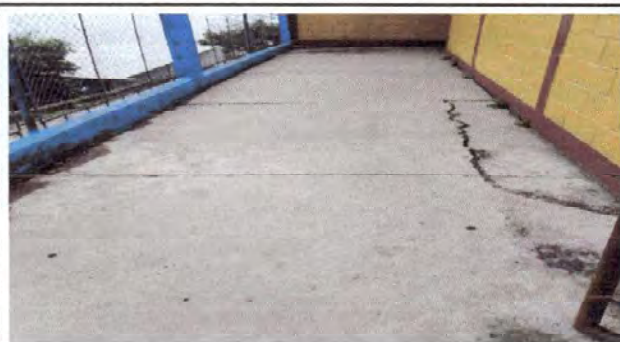
Foto 1: Reparación de plancha de concreto de patio.
