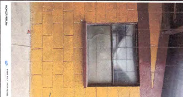
Foto 4: Sustrucción de estructura de metal de ventana por PVC módulo 1
