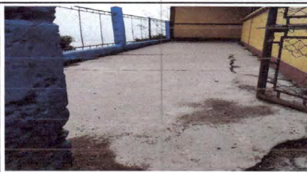
Foto 2: Reparación de plancha de concreto de patio.
