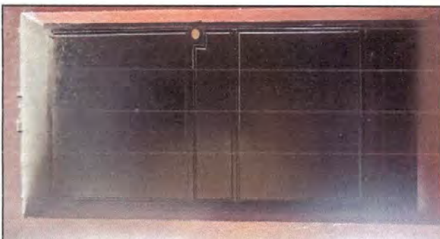
Foto 3: Sustitución de puerta de metal del módulo # 1
